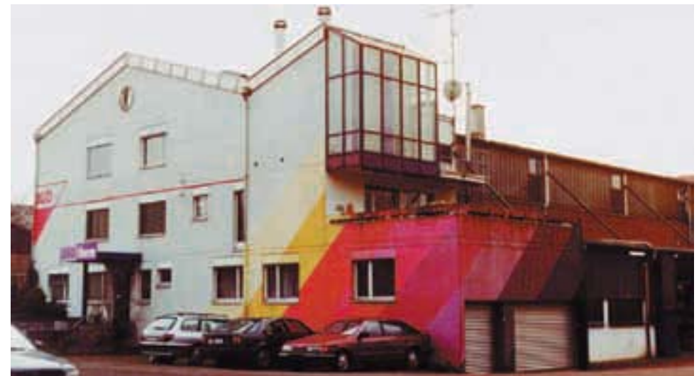
Nordwest-Fassade des Fabrikgebäudes in Fällanden (1975).
