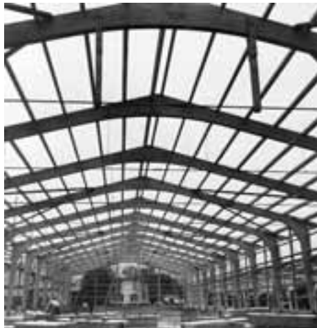
Holzkonstruktion der Lagerhalle.
