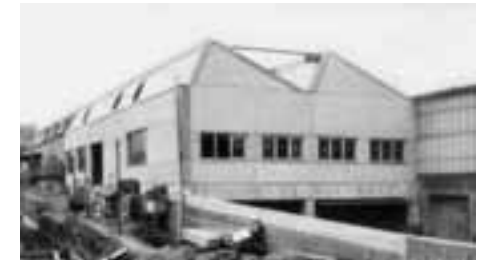
Shedbau 1982 zur Aufnahme von Vakuumöfen.
