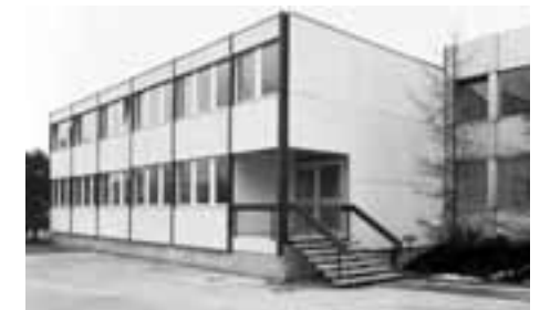
Im Anbau (1972) sind die Verkaufsabteilungen untergebracht.
