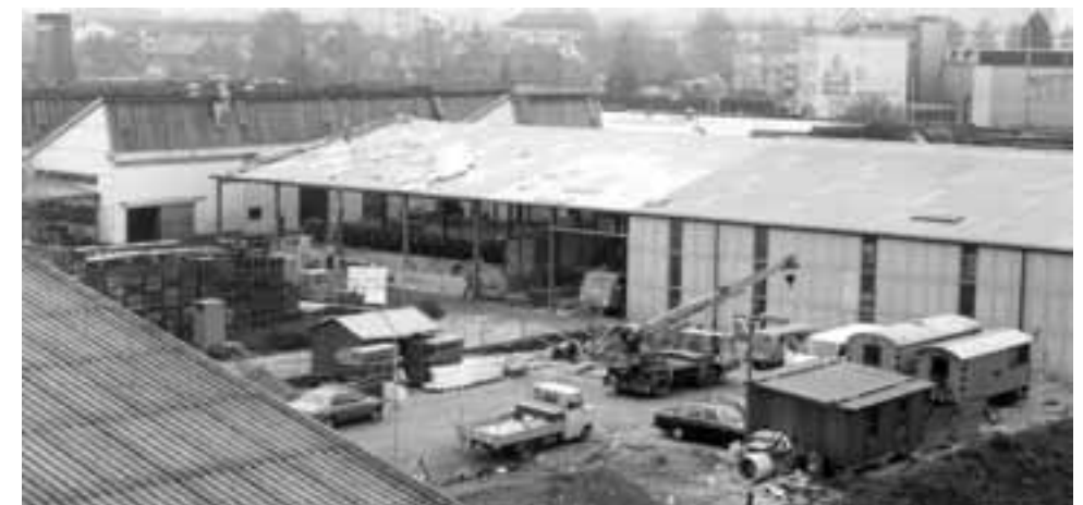
Palettenlager im Bau (1981).
