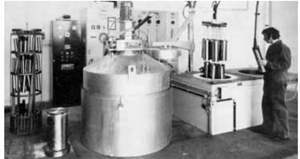
Gas-Nitrocarburieren in der Wirbelbett-Wärmebehandlungsanlage in Dürnten.
